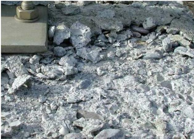
Betonbelag mit ungenügender Frosttausalzbeständigkeit:
